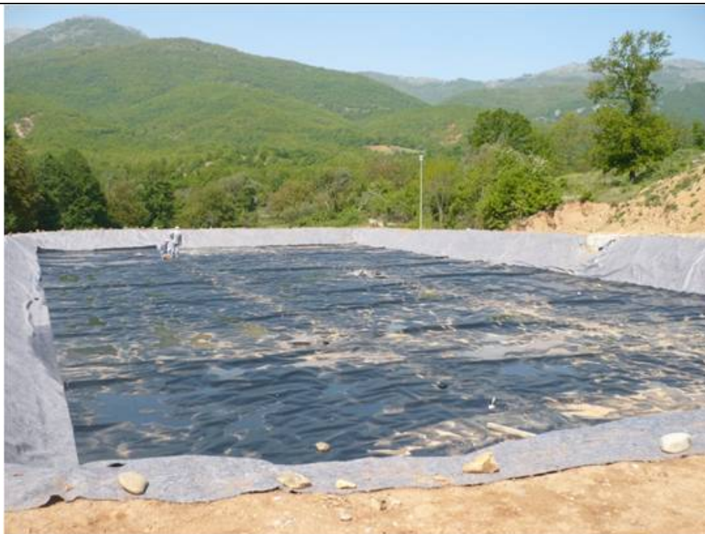
Figura 45: Instalarea geomembranei pe paturile ZUC
